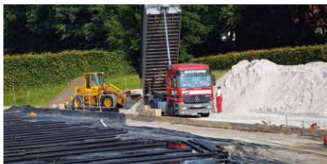
Anlage eines Platzes mit Anstausystem
