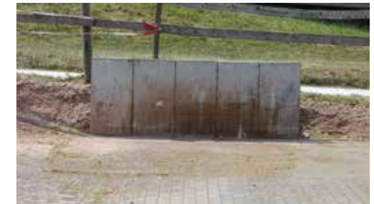
Die Betonwand erleichtert das Abmisten befestigter Teilflächen mittels Frontlader.
